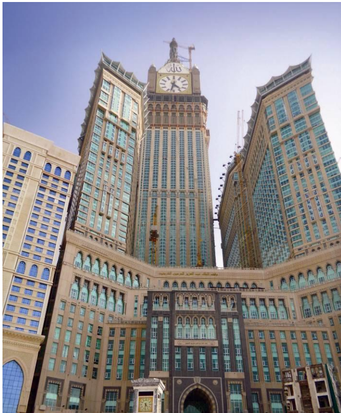
Boven: De 864 (!) meter hoge toren van het King Abdul Aziz Endowment in Mekkah wordt verlicht door Van Doorn Verlichting.
